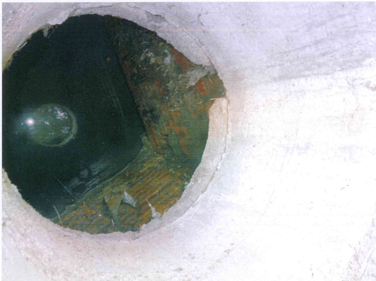
Rys.7 Komora na kanale DN1000 – ściany wewnętrzne
