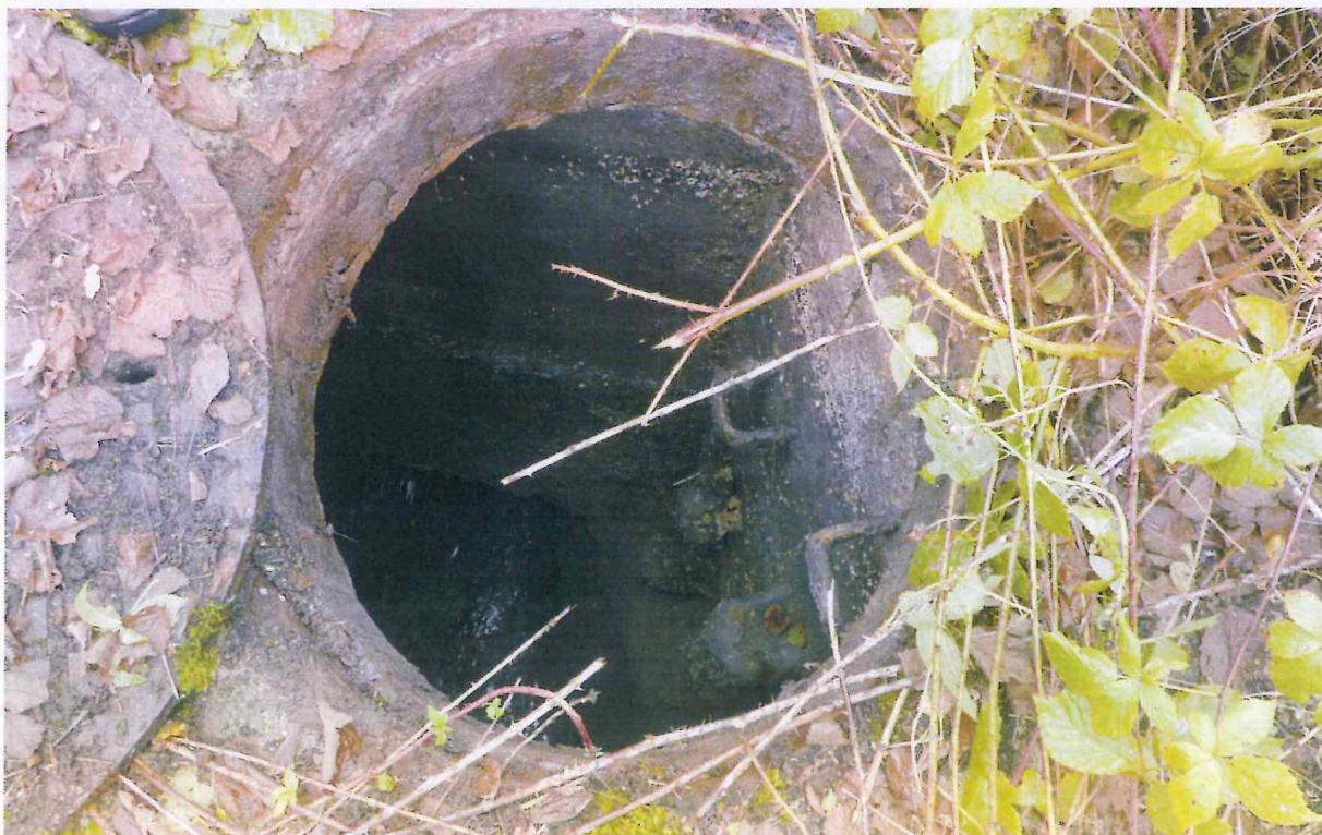
Rys.3 Komora na kanale DN1000
