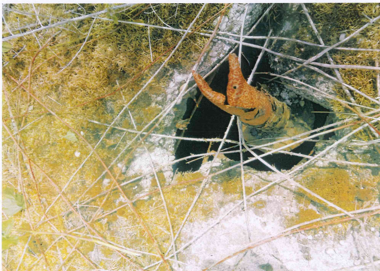
Rys.2 Armatura na kolektorze DN1000
