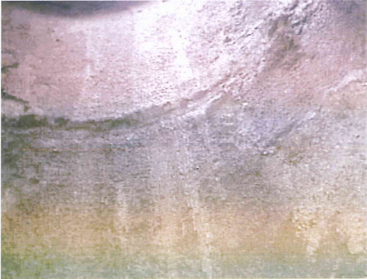
Rys.14 Komora na kanale DN300 – ściany wewnętrzne
