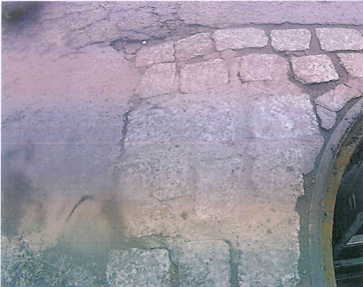
Rys.5 Komora na kanale DN1000 w pasie drogowym
